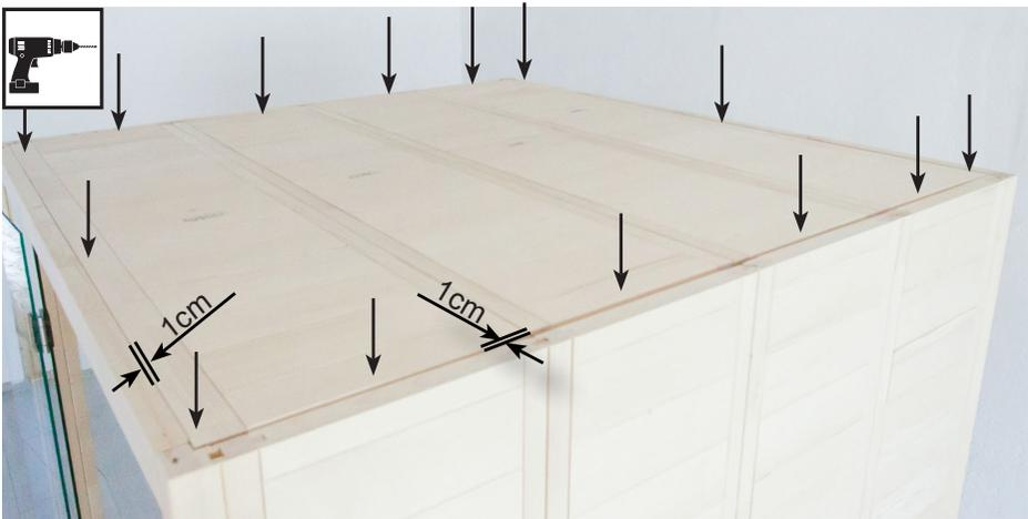
Bohrer 3 mm, 14 Stk. Schrauben 4 x 70 mm
