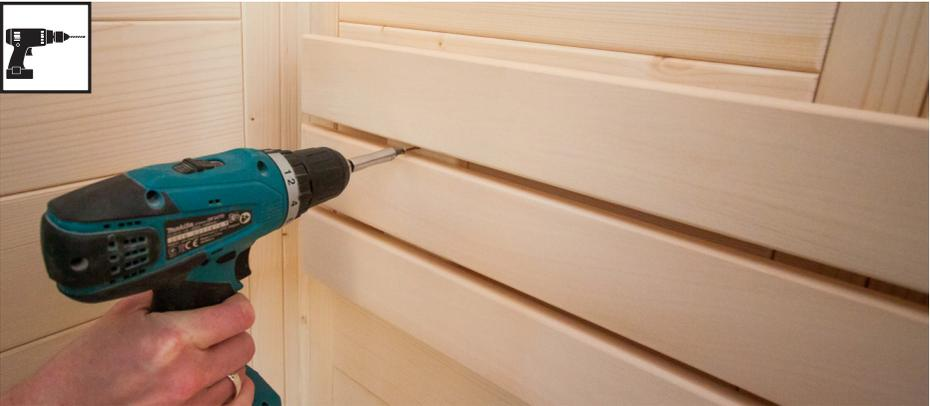
Bohrer 3 mm, 3 Stk. Schrauben 3 x 40 mm
