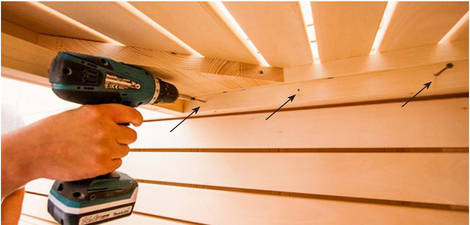
Bohrer 3 mm, 3 Stk. Schrauben 5 x 70 mm
